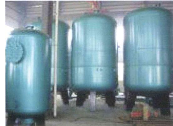
为充分发挥束状纤维滤料的特长，在过滤器的滤层下端设有可改变纤维密度的活动孔板调节装置。设备在运行时，水从下至上通过滤层。此时，活动孔板调节装置向上运动。纤维被加压后，滤层沿水流方向的密度逐渐加大，相应滤层孔隙直径和孔隙逐渐减小，实现了深层过滤。当滤层被污染需清洗再生时，清洗水从上至下通过滤层。这时，活动孔板调节装置自动下降，使纤维拉开并处于放松状态，即可方便地进行清洗。
